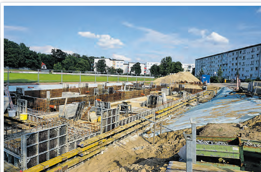
Der aktuelle Fortschritt der Baumaßnahme im Sportkomplex Heinrichslust.
