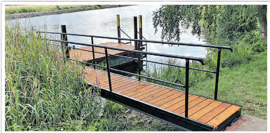
Der fertige Anlegesteg im Juli 2021.
