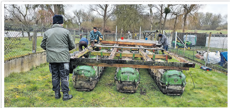
Abriss der alten Bohlen vom Stützkower Ponton im April 2021.
