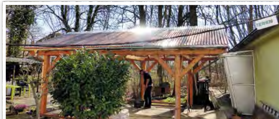
Überdachung des Besucherbereiches im Tierheim.
