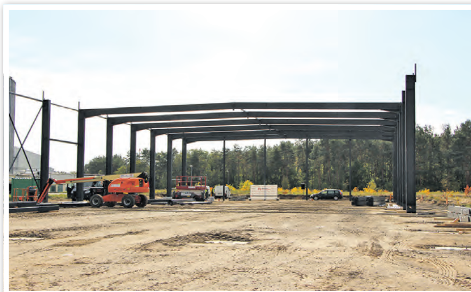
Die neue Fabrik der Firma BIO-LUTIONS im Bau.
