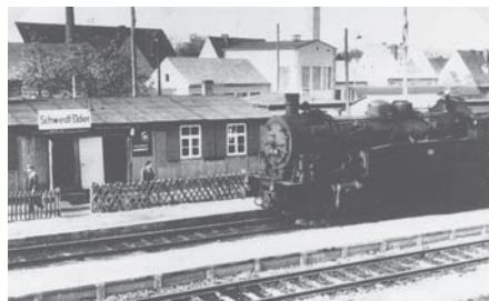
In den 60er Jahren ist die Bahnstabsbaracke für viele Schwedter der Aufbaugeneration ein bleibendes Bild, wenn es um das Ankommen in Schwedt geht.
