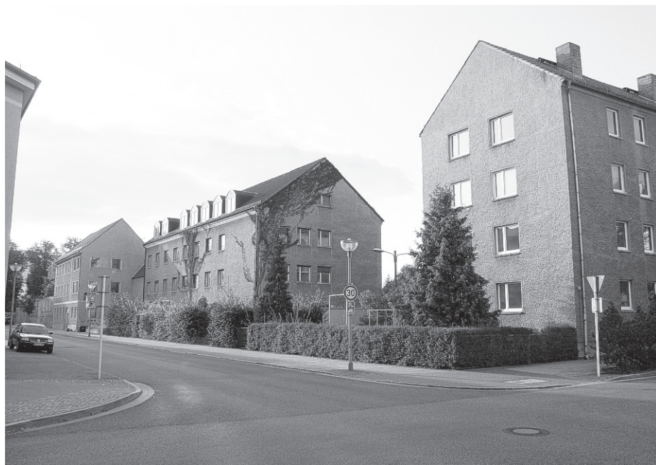
Rückbaumaßnahme „Alte Musikschule“ einschließlich aller Nebengebäude in der Karl-Marx-Straße
