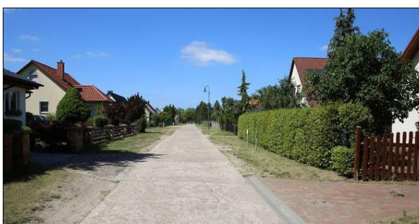
Abb. 7: Die „Straße Am Feldrain“ ist für die Anbindung des Plangebietes geeignet. Die Planung ergänzt das vorhandene Einfamilienhausgebiet.
