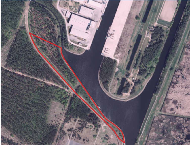
Abb.: Lage des Waldstreifens im Bereich der Welse und der Hafeneinfahrt gemäß Bebauungsplanfestsetzung "Kymmene" und heutige Situation Quelle: GOF
