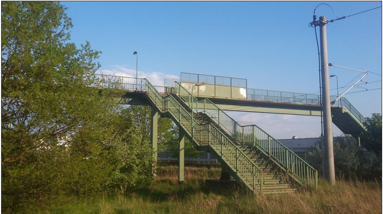
Abbildung 1: Ansicht der Fußgängerbrücke von Nordwesten
