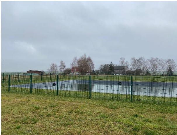
Feuerlöschteich östlich Plangebiet
