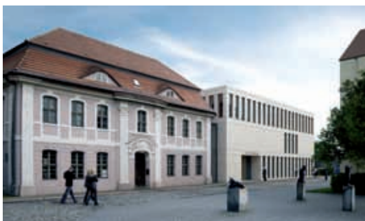
Erweiterungsbau des Kleistmuseums
