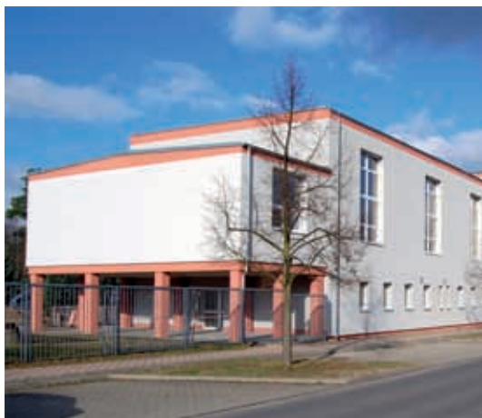
Energetische Sanierung eines Sportobjektes in Spremberg
