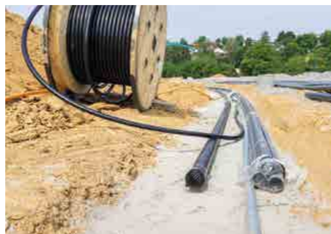
Szybkie połączenia II: budowa łącza szerokopasmowego
