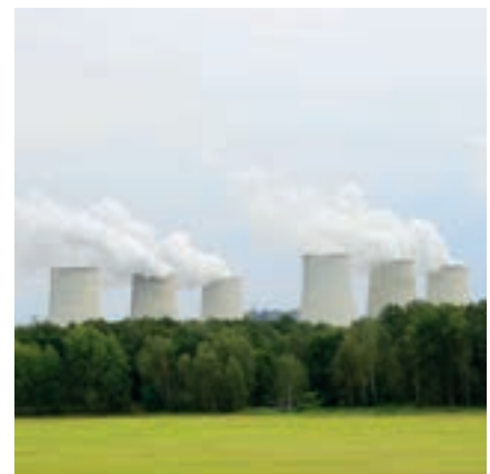
Energieproduktion im Kraftwerk Jänschwalde
